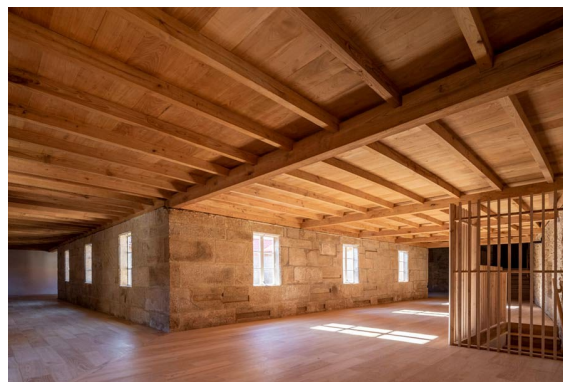
Imagen 2. Proyecto obra revestimiento madera.
