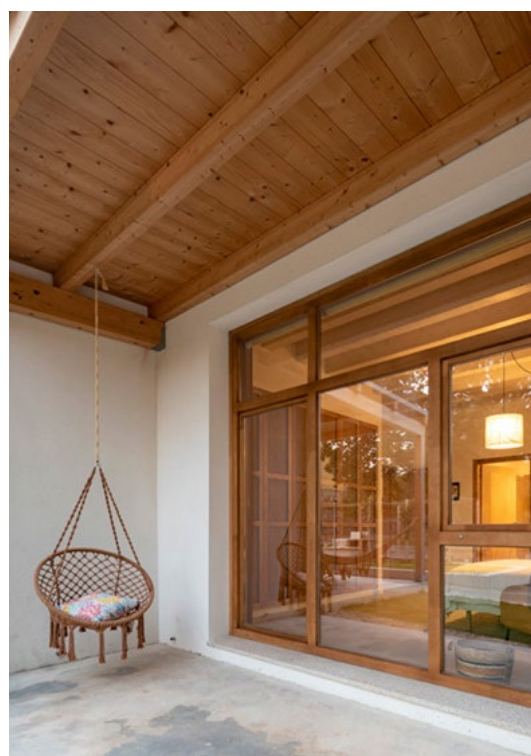
Figure 2. Projet réalisé avec des des carrelats lamellés collés en bois
