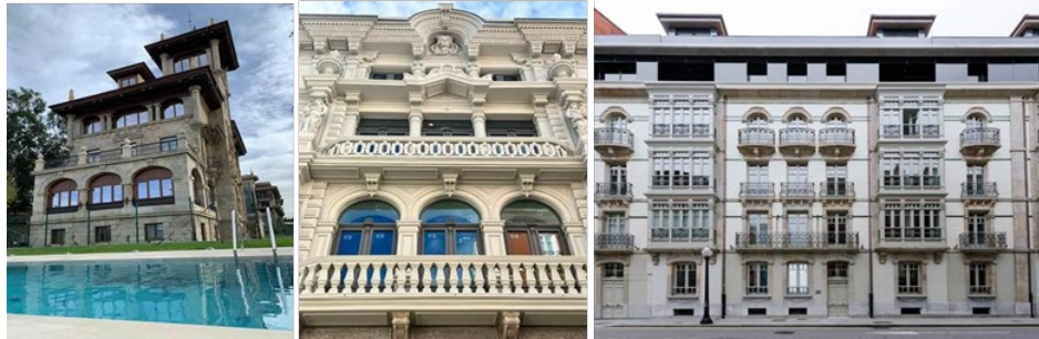
Imagen 2. De izquierda a derecha: Palacio Eguzkialde (Getxo – Bilbao), Sede banco Santander (Santander), Restauración edificio calle Marqués de Casa Valdés (Gijón).
