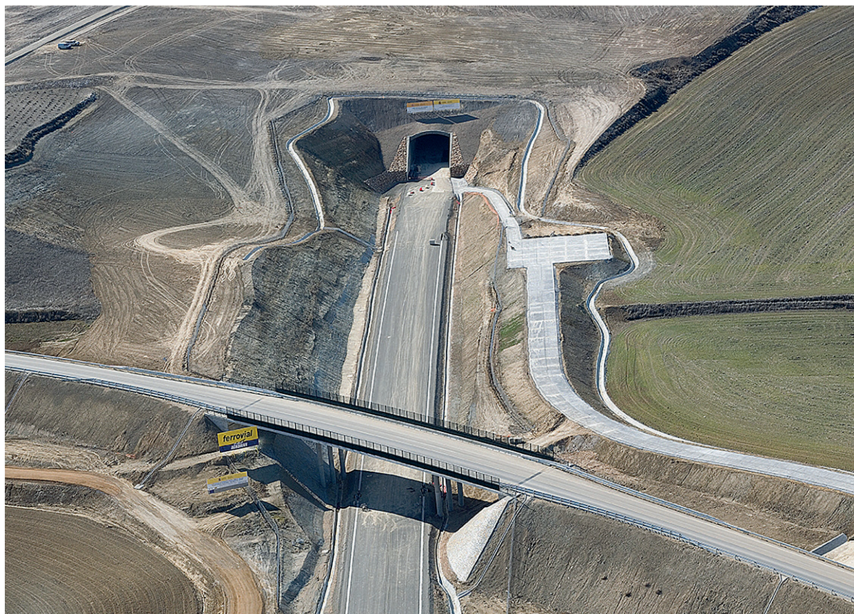
Línea de Alta Velocidad Valladolid-Burgos, "Túnel Peñarroya" (Valladolid).
