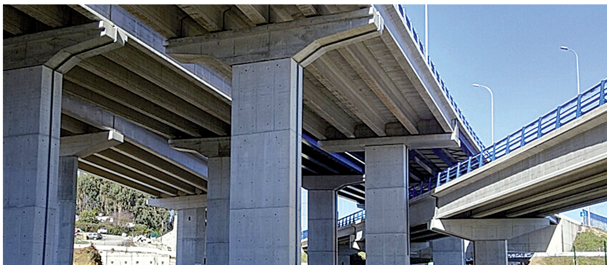
Autovía de acceso a La Coruña y conexión aeropuerto. Tramo Lonzas-A Zapateira. Galicia.
