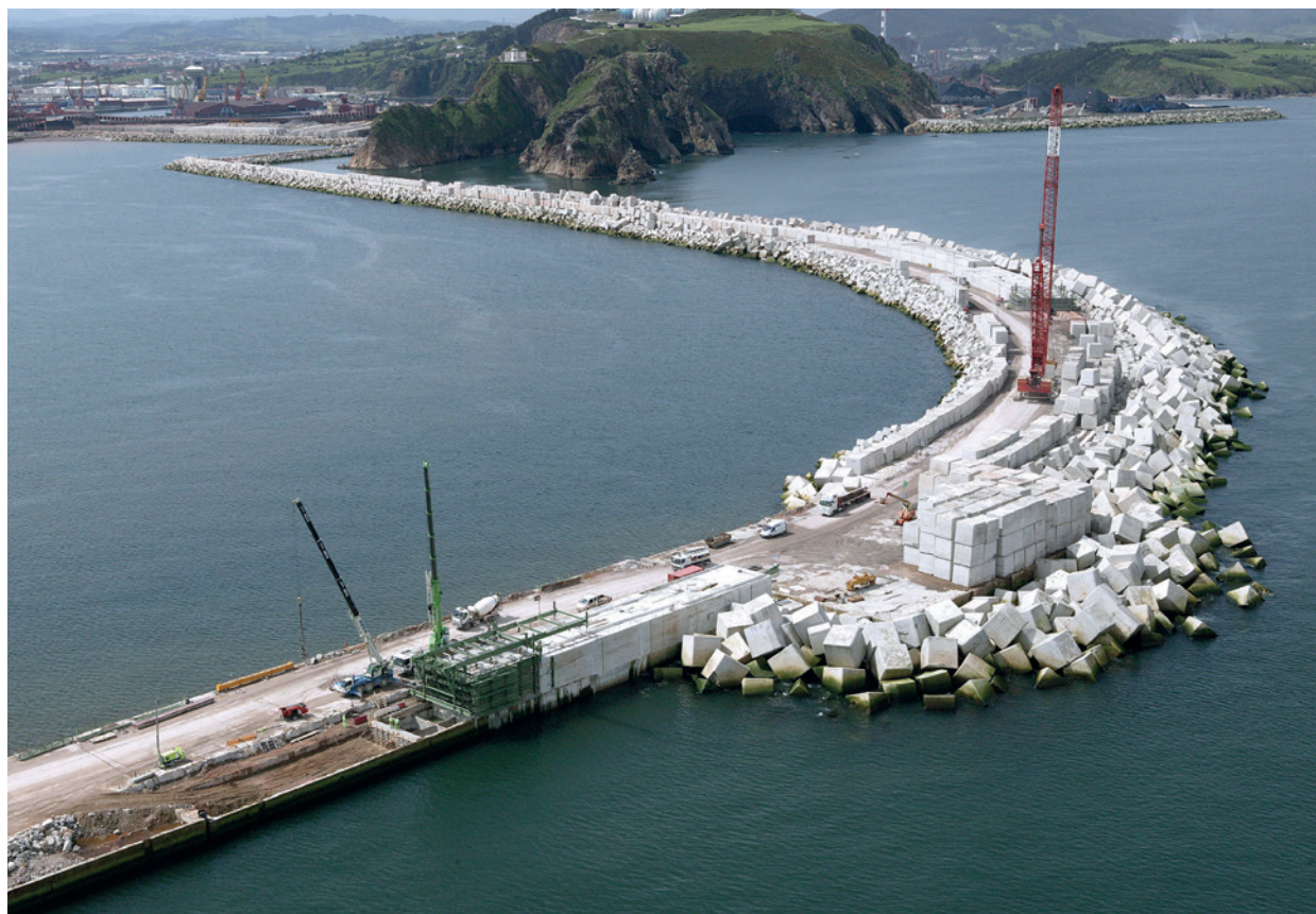
Obras de ampliación del Muelle. Gijón. Asturias.
