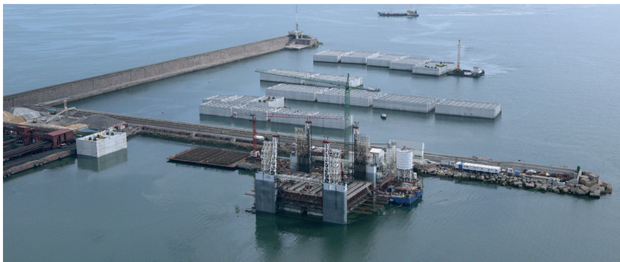
Obras de ampliación del Musel. Gijón. Asturias.
